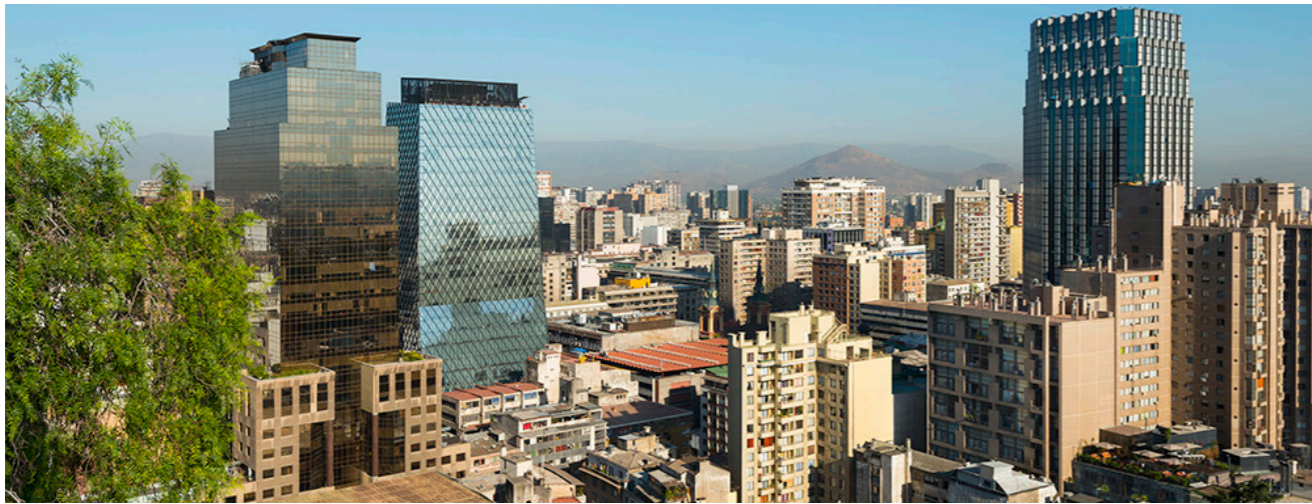
VISTA DESDE EL CERRO SANTA LUCÍA HACIA SUBMERCADO SANTIAGO CENTRO.
